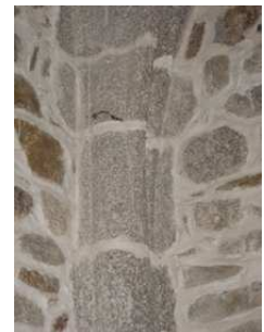
Colonne de la chapelle Sud.
